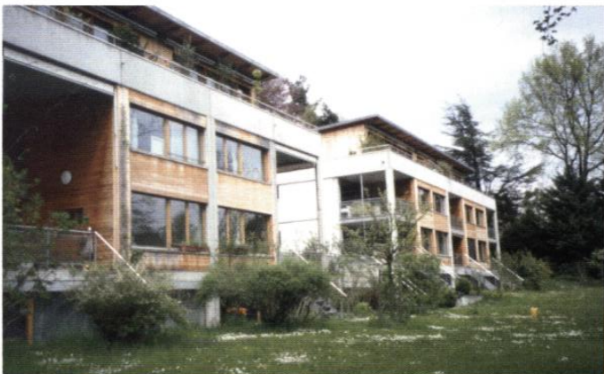
▲ L'implantation des immeubles a permis de préserver un pré commun vers lequel s'ouvrent les terrasses et les loggias de chaque appartement
