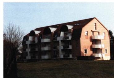
▲ Immeubles accessibles depuis la route de Séléstat
