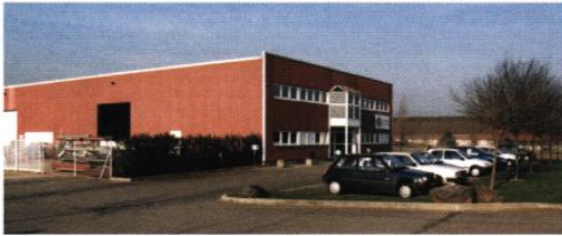
▲ Le site de l'entreprise est structuré en zones bien différenciées. Sur rue, une bande verte plantée d'arbres marque la limite entre le domaine public et le site de l'entreprise. Le stationnement s'organise à l'arrière de la bande verte et ménage l'espace d'accès aux bureaux. Le dépôt extérieur s'implante latéralement. Il est clos par une haie doublée d'un grillage. La cour est ainsi protégée physiquement et visuellement.
