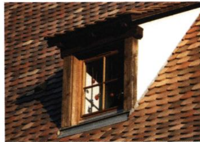
▲ Lucarne et couverture en tuiles plates à double recouvrement
