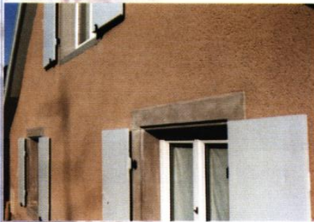
Enduit à la chaux aérienne naturelle ▲
