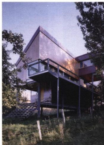
▼ Structure acier galvanisé, panneaux en contre-plaqué
