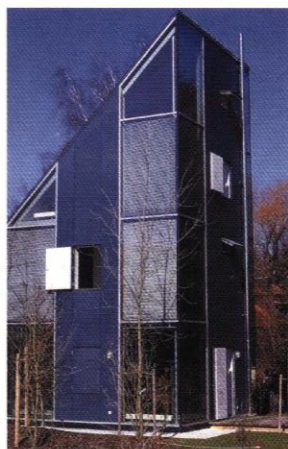
▲ Ossature en panneaux multiplis structurels, vêtue extérieure en contreplaqué peint
